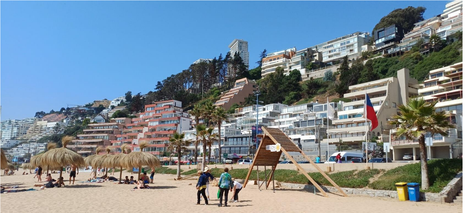
Edificios de viviendas, con terrazas – miradores, en Playa Cochoa - Viña del Mar, Chile. Fotografía archivo de Jorge Enrique Bejarano Briñez
